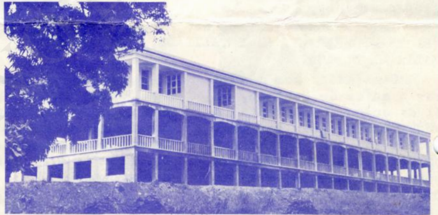
Aspecto parcial do Hospital de Cabinda
